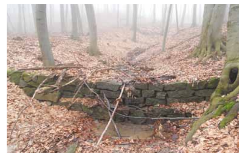
A fenékgát megakadályozza a hordalék okozta eróziót
